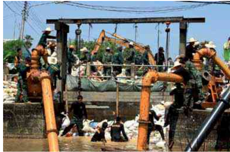
อุบลรัตน์ - ทหารกำลังอุดรอยรั่วด้วยกระสอบทราย และตอกเสาเข็ม ที่ประตูน้ำคลองบางโจว ซึ่งรับน้ำจากคลองเชียงราก เพื่อไม่ให้ท่วมโรงงานอุตสาหกรรมบางกะดี - Dilok Tamjaipuan Pathum Thani - Soldiers are stacking sand bags and reinforcing with concrete piles a leakage at the Khlong Bang Ngiew Sluice to prevent flooding at Bang Kadee Industrial Park - Dilok Tamjaipuan
