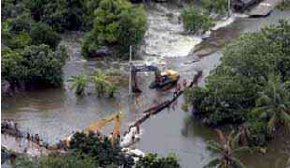
พทุมธานี - เร่งซ่อมคันกันน้ำที่พังพังหลายจุด - จิราพร คำภาพินธ์ Pathum Thani - Workers hurriedly repair a collapsed earthen flood wall - Jiraporn Khamphaphan
