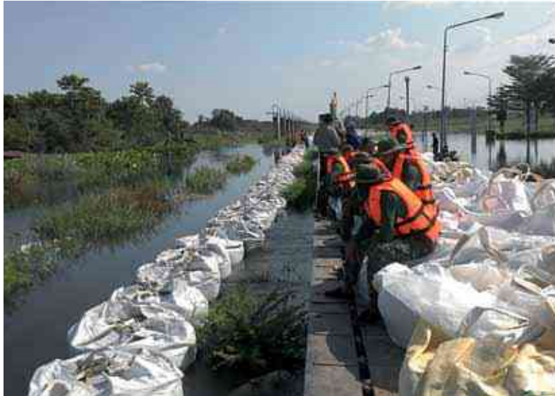
เจ้าหน้าที่กรมกว่า 200 นายวางกระสอบทรายบิ๊กแบ็กที่ต้นหลักาก จังหวัดปทุมธานี จนถึงหน้าถนนบนถนนเมืองระยองยาว 6 กิโลเมตร เป็นจุดสร้างความขัดแย้งระหว่างชาวบ้านที่อยู่ทั้งสองด้านของคันกันน้ำนี้ — ชีรภาพร ขำภพพาน
