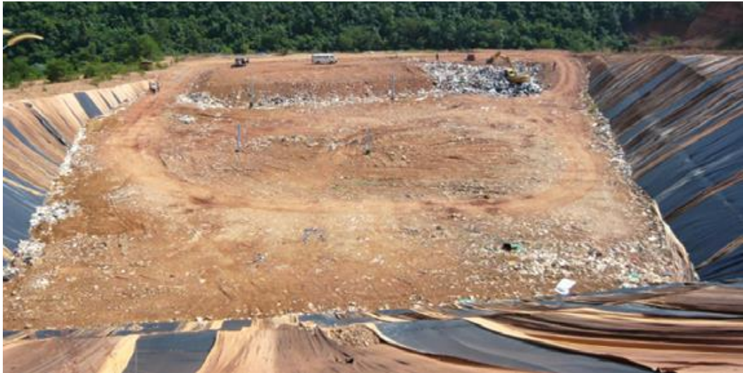
ภาพที่ 2-8 วิธีฝังกลบแบบหุบเขา
