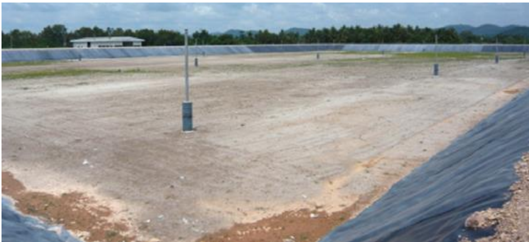
ภาพที่ 2-7 วิธีฝังกลบแบบขุดร่อง
